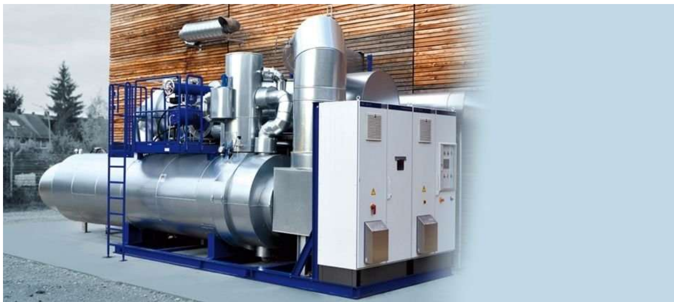
Obr. 5: příklad instalace ORC DURR CYPLAN 250.
